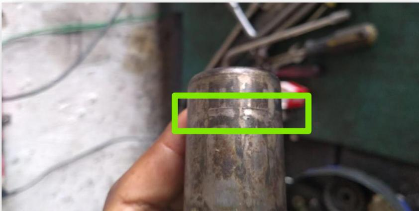
Notem que há um “calo” (degrau) na superfície do tubo guia. Mesmo assim, o rolamento novo foi montado sobre ele.
